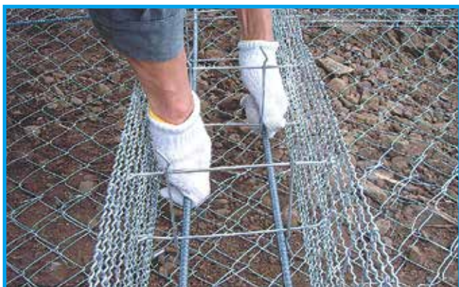
下筋設置状況
